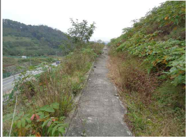
1소단 배수로 전경
