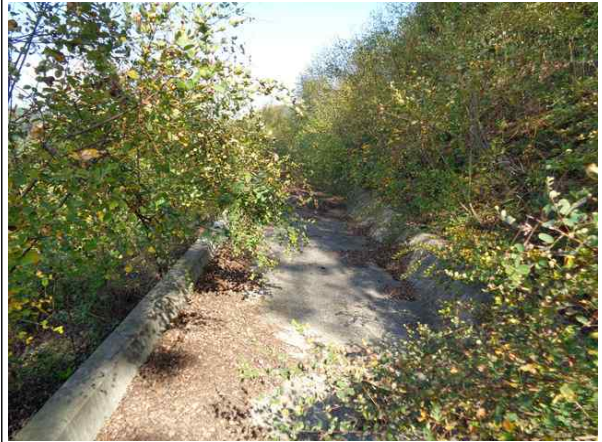
1소단 배수로 전경
