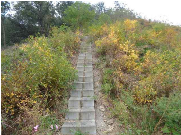
콘크리트 점검계단 전경
